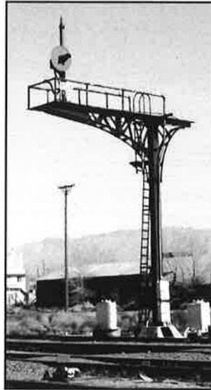
Signal lumineux sur portique avec un seul boîtier pour les deux couleurs.
